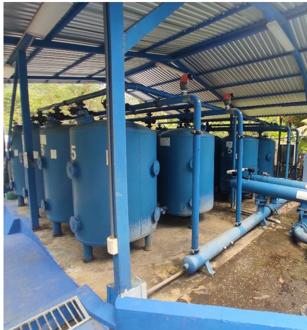
Ilustración 22 Proceso de Filtración
