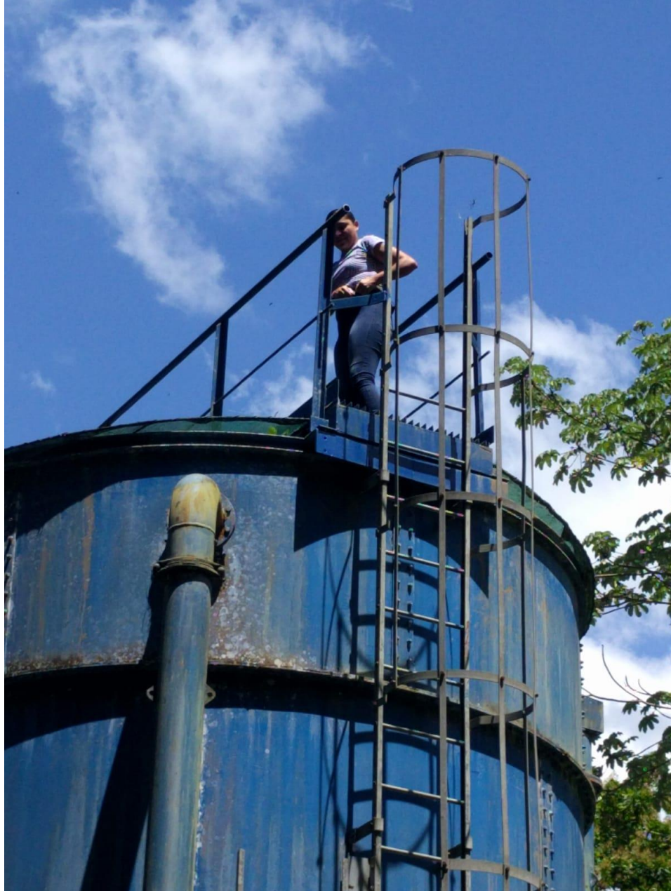
Ilustración 32. Ensayo de trazadores de floculador/sedimentador
