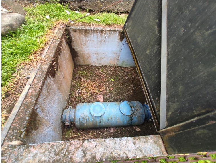
Ilustración 19 Proceso de Coagulación (mezclador estático)
