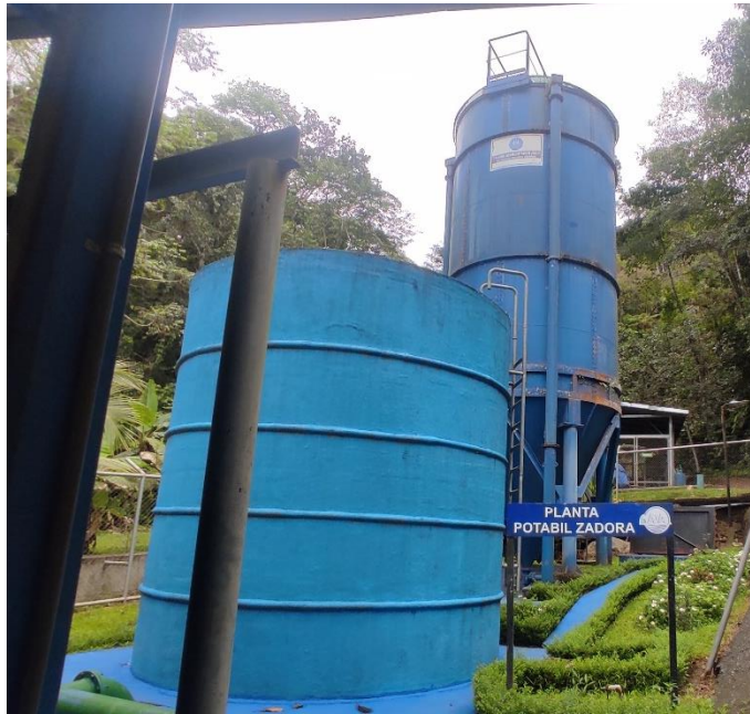
Ilustración 23 Proceso de Floculación-Sedimentación
