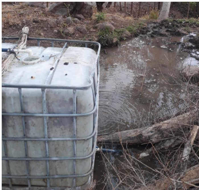
Figura 31 Fuga 2 de tubería que conduce agua de las cámaras de contacto a la planta potabilizadora
