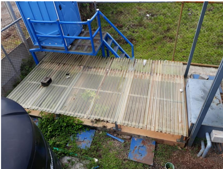
Figura 7: Lecho de secado, tres unidades de secado de lodos.
