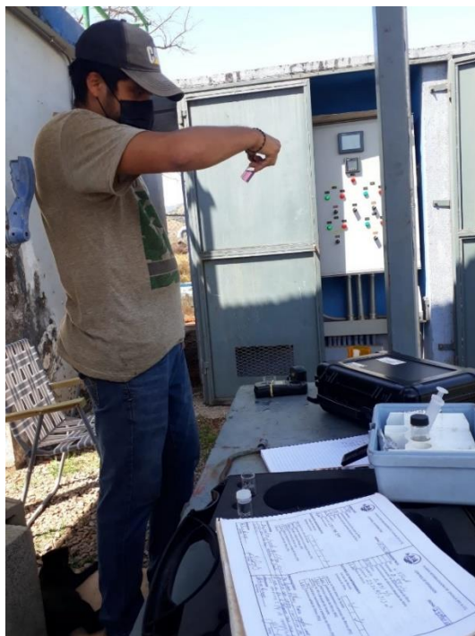
Figura 27 Medición de cloro residual al final del proceso de potabilización
