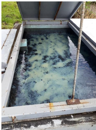
Figura 10: Tanque flocculador ascendente (flocculador – sedimentador), de concreto reforzado
