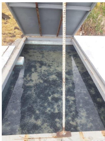
Figura 22 Aluminio precipitado en la parte superior del floculador ascendente (floculador – sedimentador)
