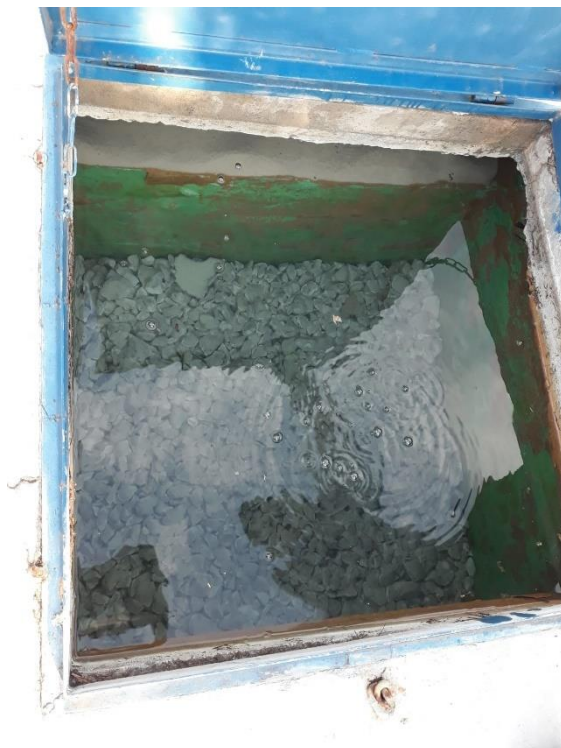
Figura 21 Piedra caliza de cámara de contacto 2, primera etapa de tratamiento del agua de las nacientes de cabuyal.
