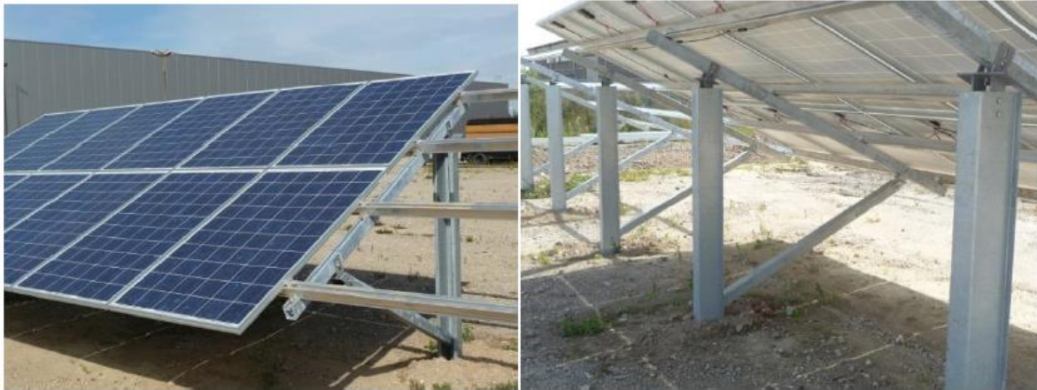
Fijación de estructura al suelo, de acero galvanizado, vista frontal y trasera.
