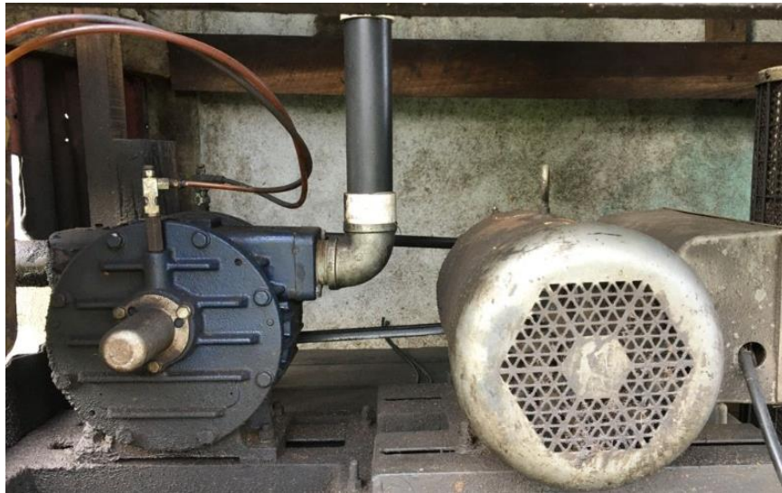
Figura No.21. Sistema de vacío, proceso de ordeño
