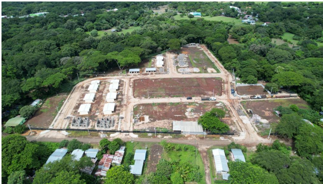
Anexo 24. Vista General del proyecto. (comunicación personal, diciembre 17, 2021)
