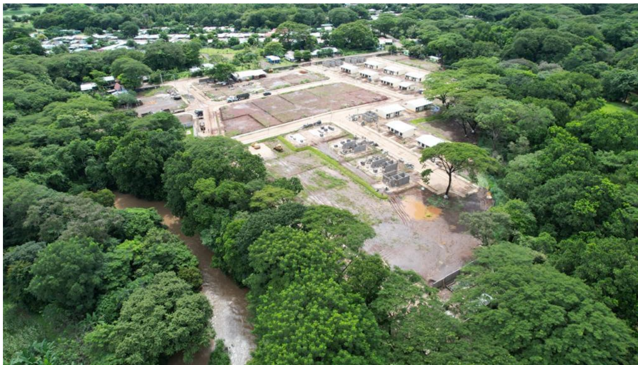
Anexo 25. Vista General desde la estación de bombeo. (comunicación personal, diciembre 17, 2021)
