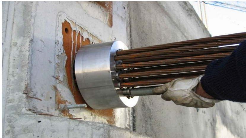
Figura 11. Sistema de presforzado de concreto
