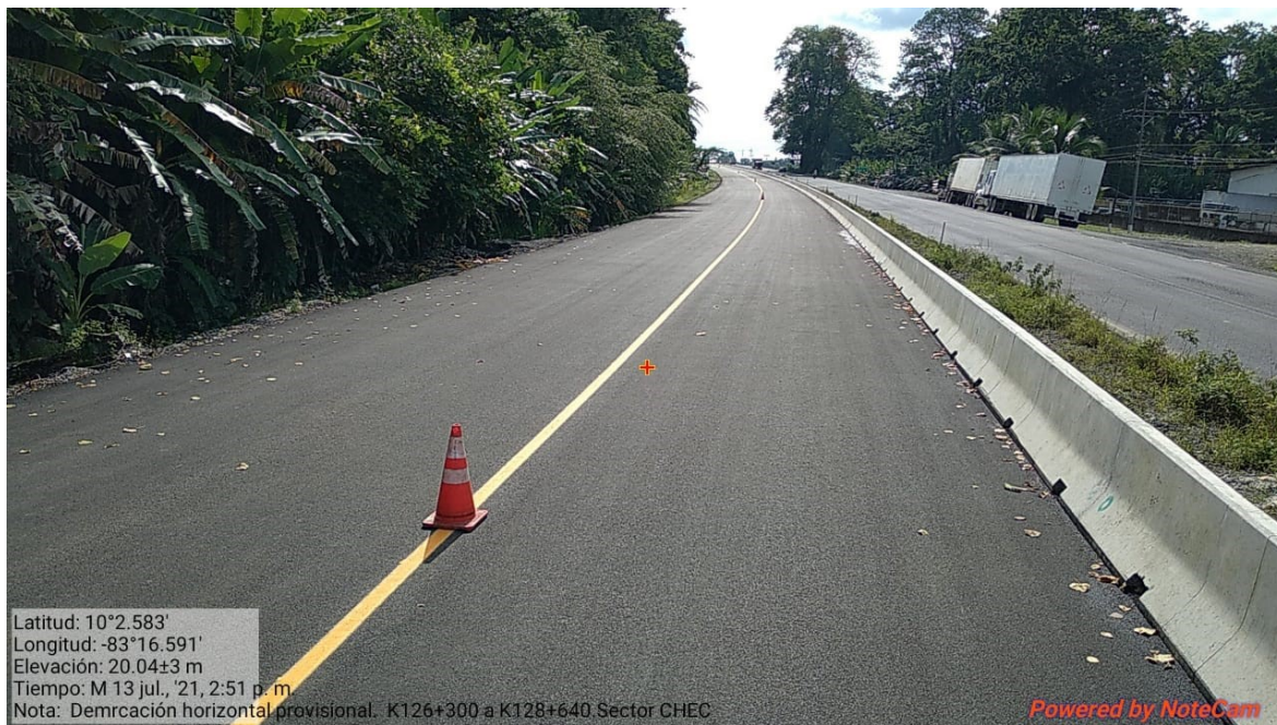
Figura 4. Tramo de prueba
