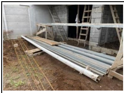
7 Material en obra
