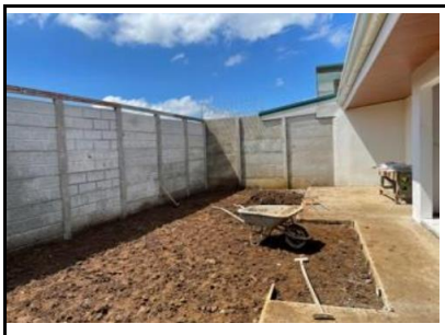
3 Vista interna, paredes levantadas
