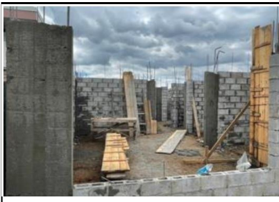
3 Vista interna, paredes hasta altura de viga corona
