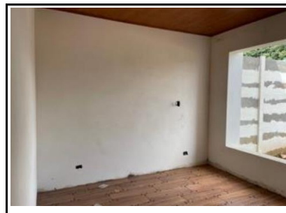
8 Repello paredes internas
