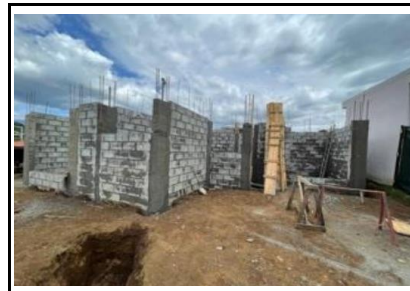
4 Paredes de bloques de concreto
