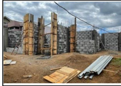
2 Vista interna, formaleta para colado de concreto para columnas
