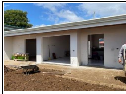
4 Vista estructura de techo y cubierta
