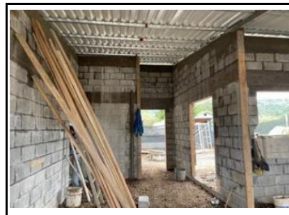
4 Vista estructura de techo y cubierta
