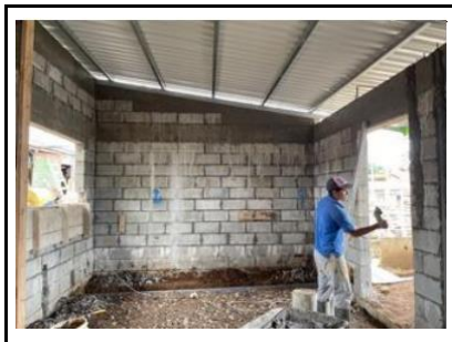
3 Vista interna, paredes levantadas
