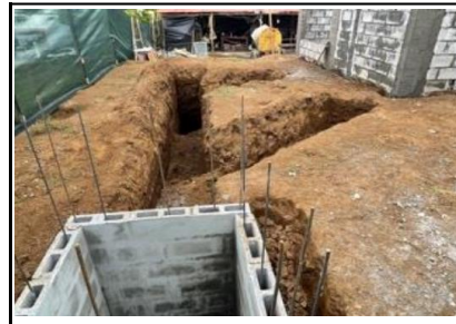
6 Excavación para drenajes y paredes del tanque séptico
