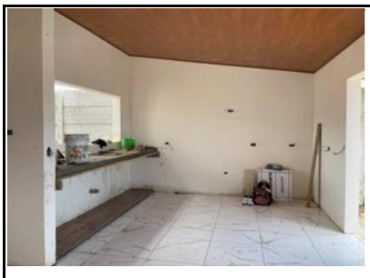
7 Material en obra
