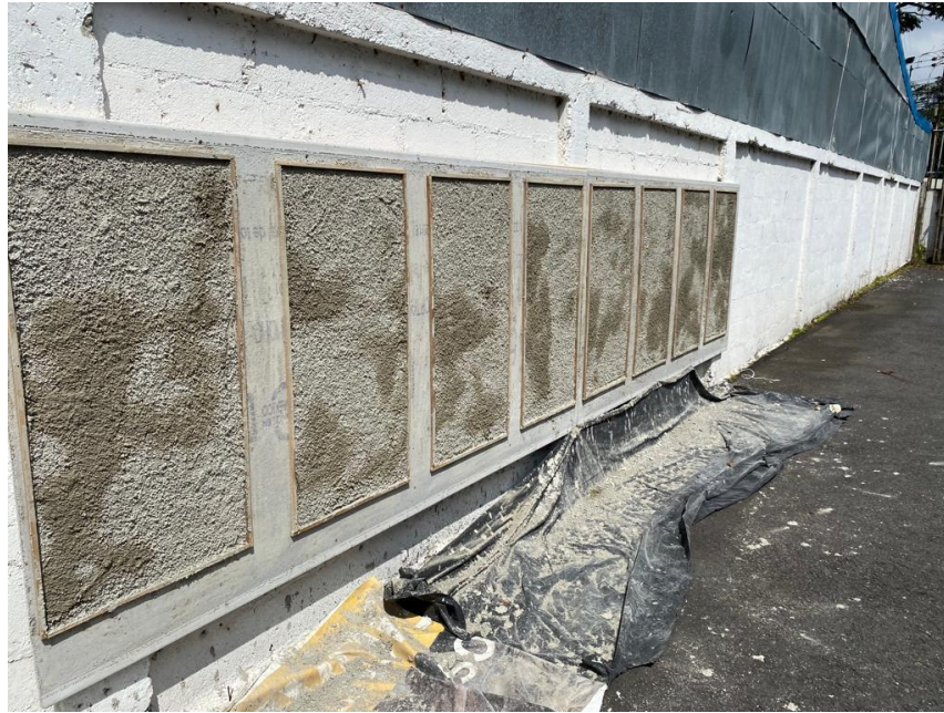
Figura 14: Laminas de Durock con capa de pringado aplicada
