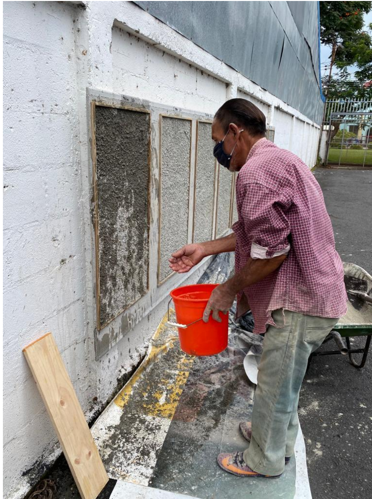
Figura 15: Aplicación de agua a cada uno de los paños antes de realizar el repello maestreado
