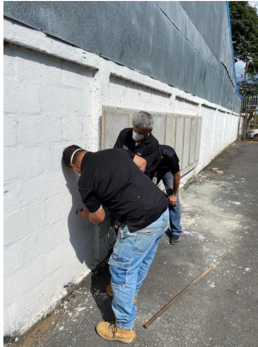
Figura 25: Desprendimiento de la pared falsa
