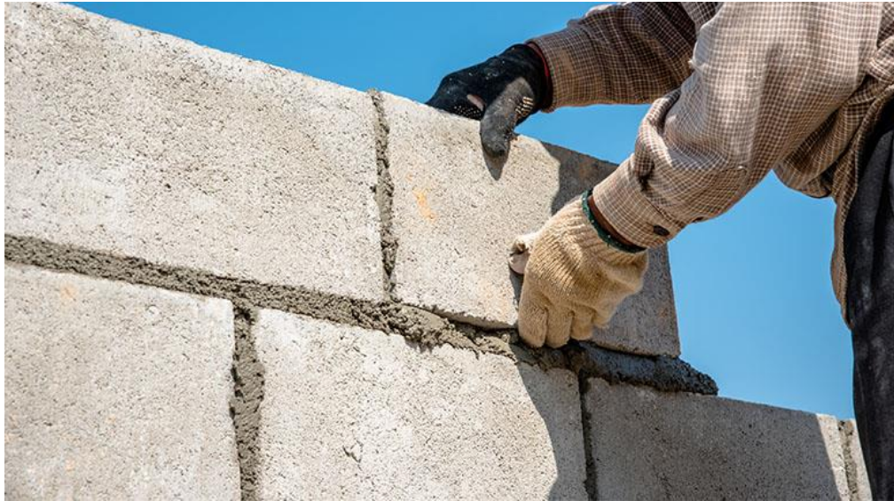
Figura 1. Proceso de pega de bloques utilizando mortero de pega
