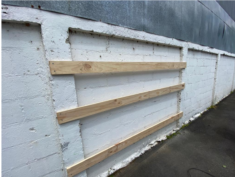
Figura 8: Ubicación de reglas de madera
