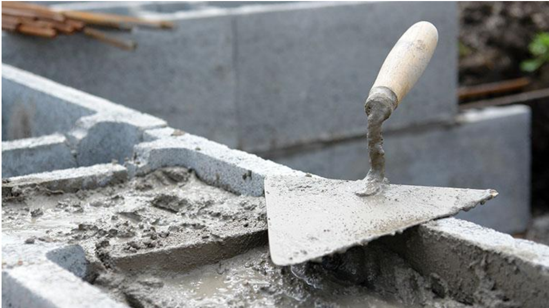
Figura 2: Relleno de bloques de mampostería con mortero de relleno
