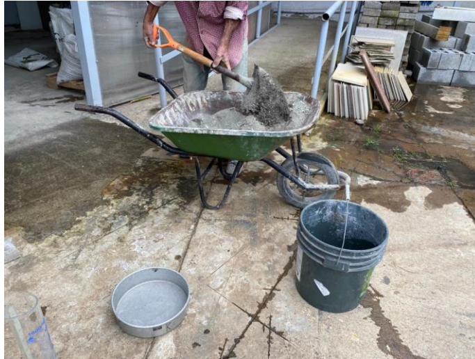
Figura 19: Preparación de la mezcla de componentes para realizar la mezcla de mortero
