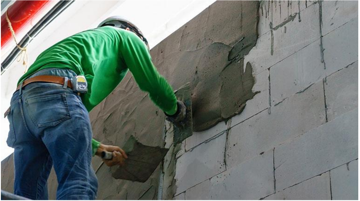
Figura 3: Repello de una superficie con mortero de recubrimiento
