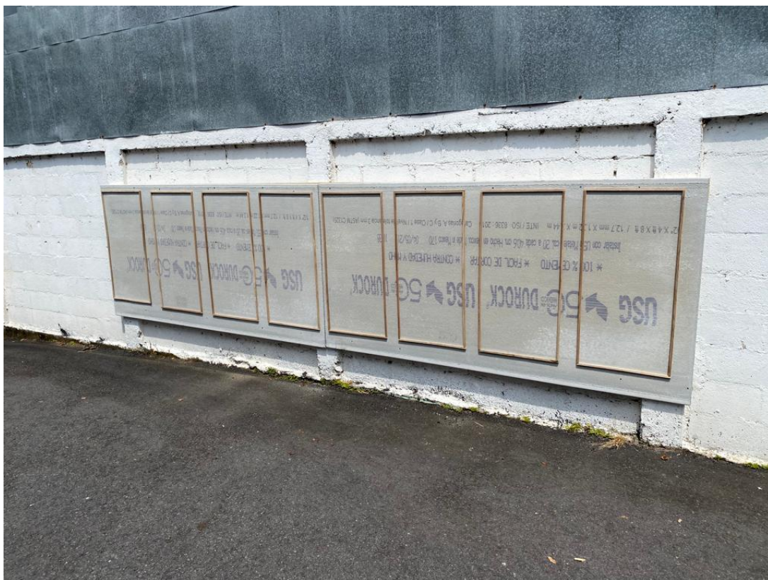
Figura 10: Láminas de Durock colocadas sobre la pared
