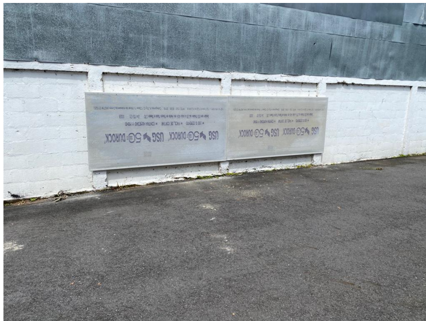
Figura 9: Laminas de Durock colocadas sobre la pared
