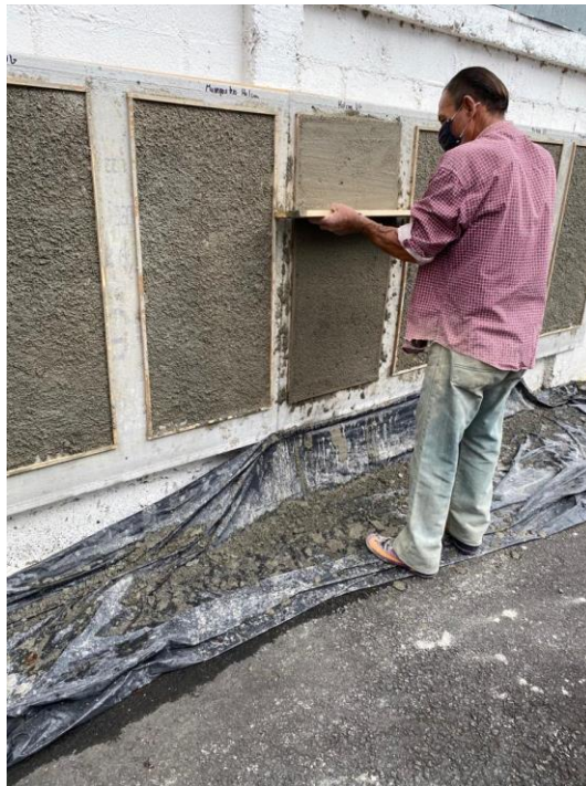
Figura 20: Repello maestreado con la utilización del codal
