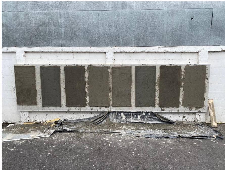
Figura 21: Paños de repello con su capa de repello ya aplicada
