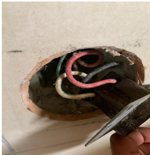
Figura 48. Instalación de receptáculos especial 240V
