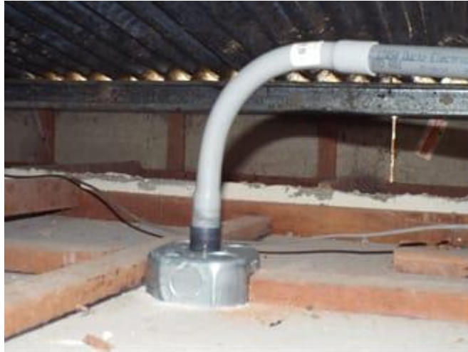
Figura 41. Correcta manipulación de la tubería
