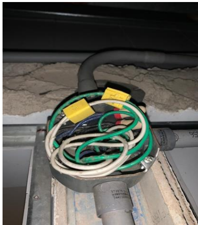
Figura 42. Conexión en cajas octogonales
