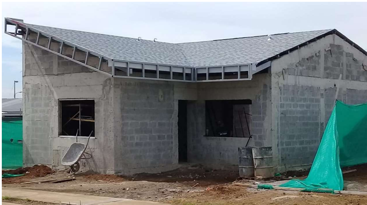
Figura 4. Vivienda construida con sistema de mampostería reforzada mixta
