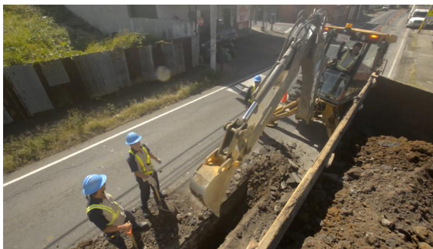
Ilustración 9. Excavación para alcantarillado sanitario Fuente: ESPH S.A., julio 2020
