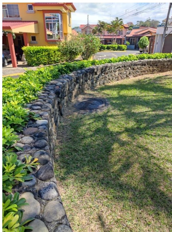
Anexo 32. Pozo de registro ubicado en el Residencial Real Santa María del Este
