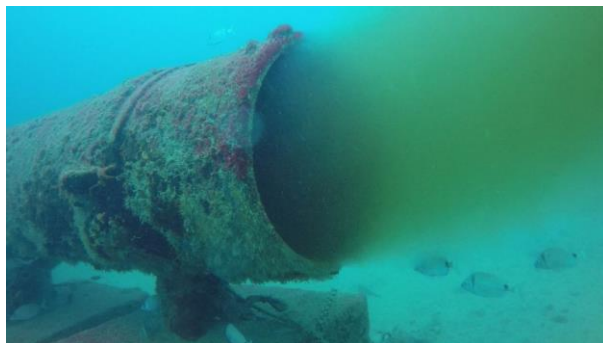
Ilustración 12. Punto de descarga de las aguas tratadas
