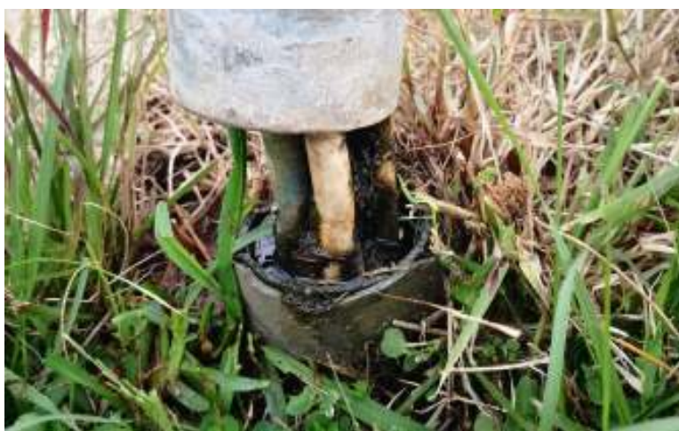
Figura 3.3: Inicio tubería subterránea. Fuente: Propia.
