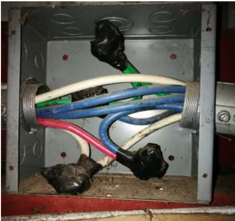
Figura 3.5: Empalmado del cable de acometida en el interior del edificio. Fuente: Propia.
