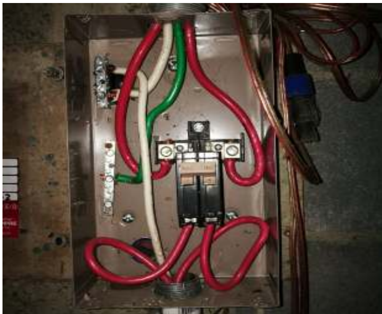
Figura 3.8: Centro de carga principal, bodega principal. Fuente: Propia.
