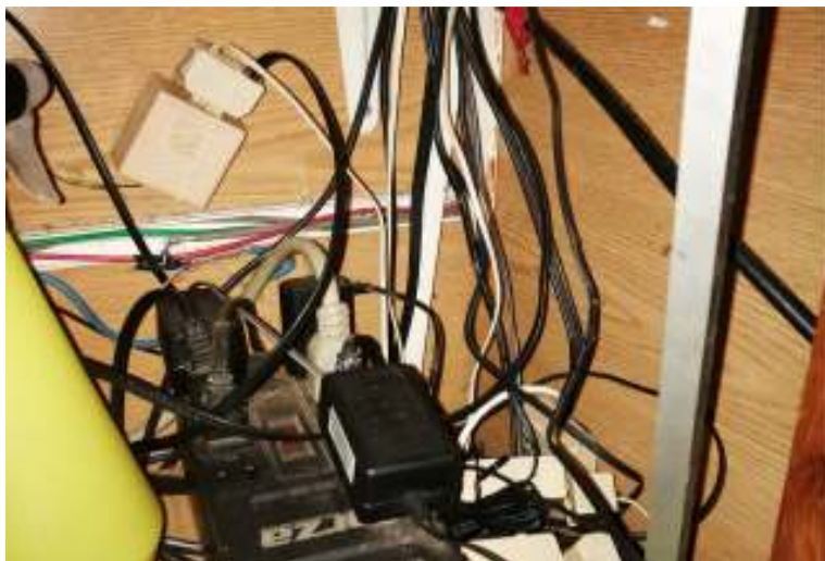
Figura 3.12: Conexión cableado mueble de la caja. Fuente: Propia.
