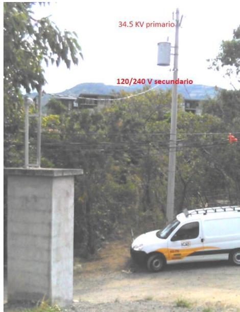
Figura 3.23: Transformador de 34.5 Kv Primario y 120/240V Secundario.
